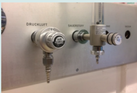
Erogatore di aria compressa con valore predeterminato ed erogatore di ossigeno regolabile
