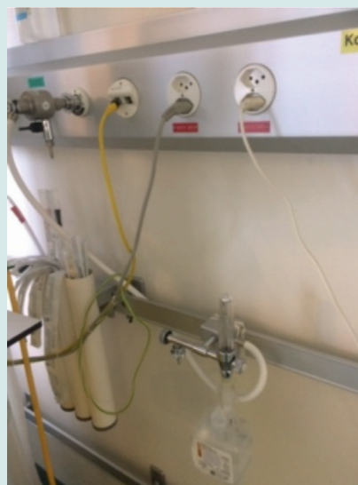
Aria compressa sopra, ossigeno sotto
